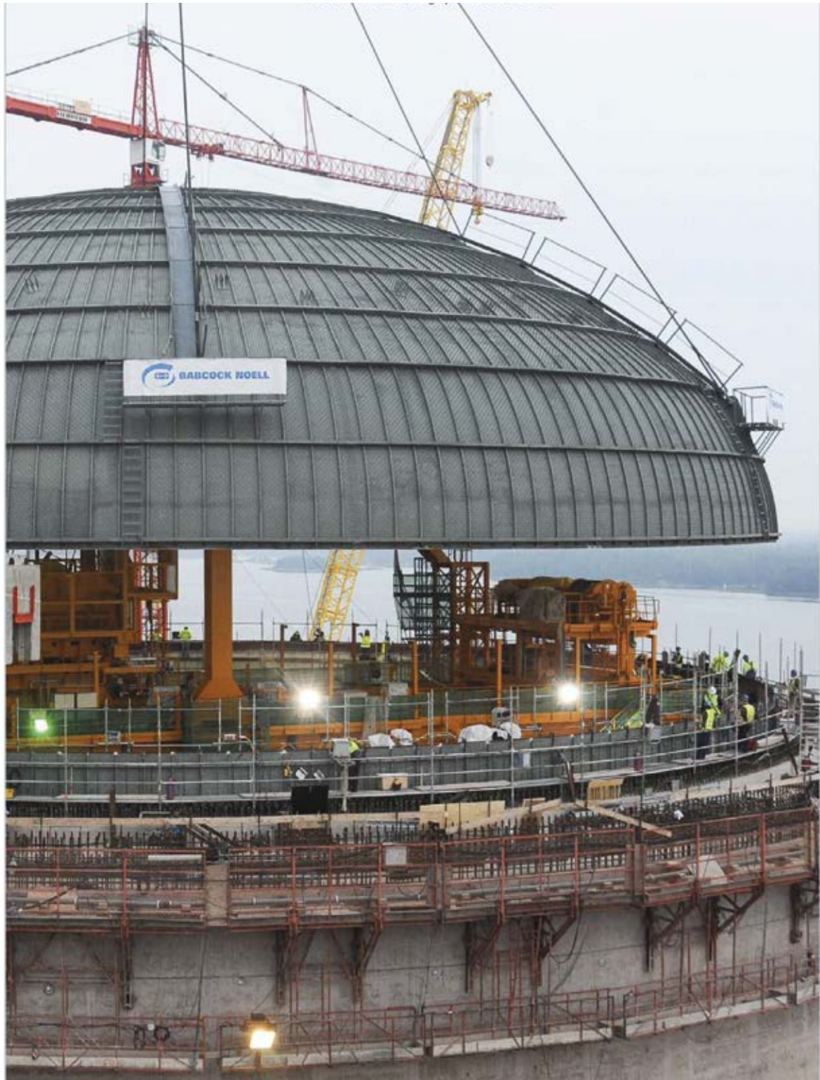
Lyft av stålfodringens kupoldel i november 2009.
