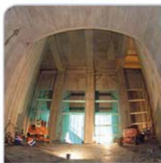
Tvärytan på intagstunneln för kylvatten är cirka 60 m 2 .
