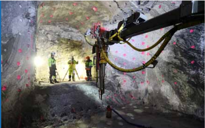
Loppusijoitustunnelin testitulpan paikka on työstyetty erityisellä tarkkuudella.
