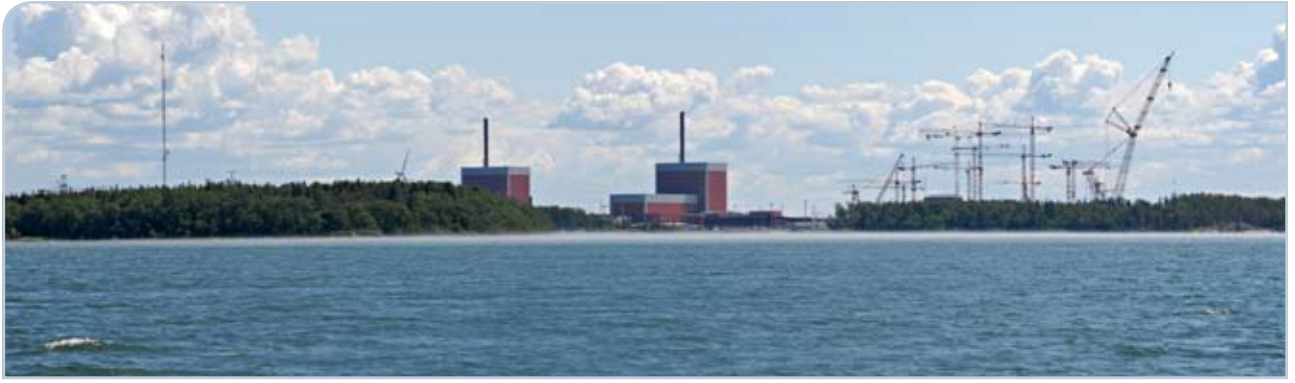
Kuva 9-28 Olkiluodon saari mereltä päin katsottuna. Kuvassa näkyvät nykyiset laitosyksiköt OL1 ja OL2 sekä kuvassa oikealla OL3:n rakennustyömaa.
