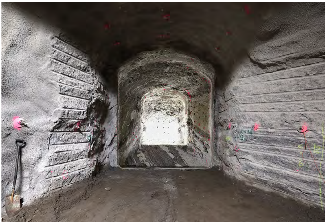
Kuva 4-5. POPLU-tulpan paikka valmiiksi louhittuna vuonna 2014 ONKALOn demonstraatiotunnelissa 4.
