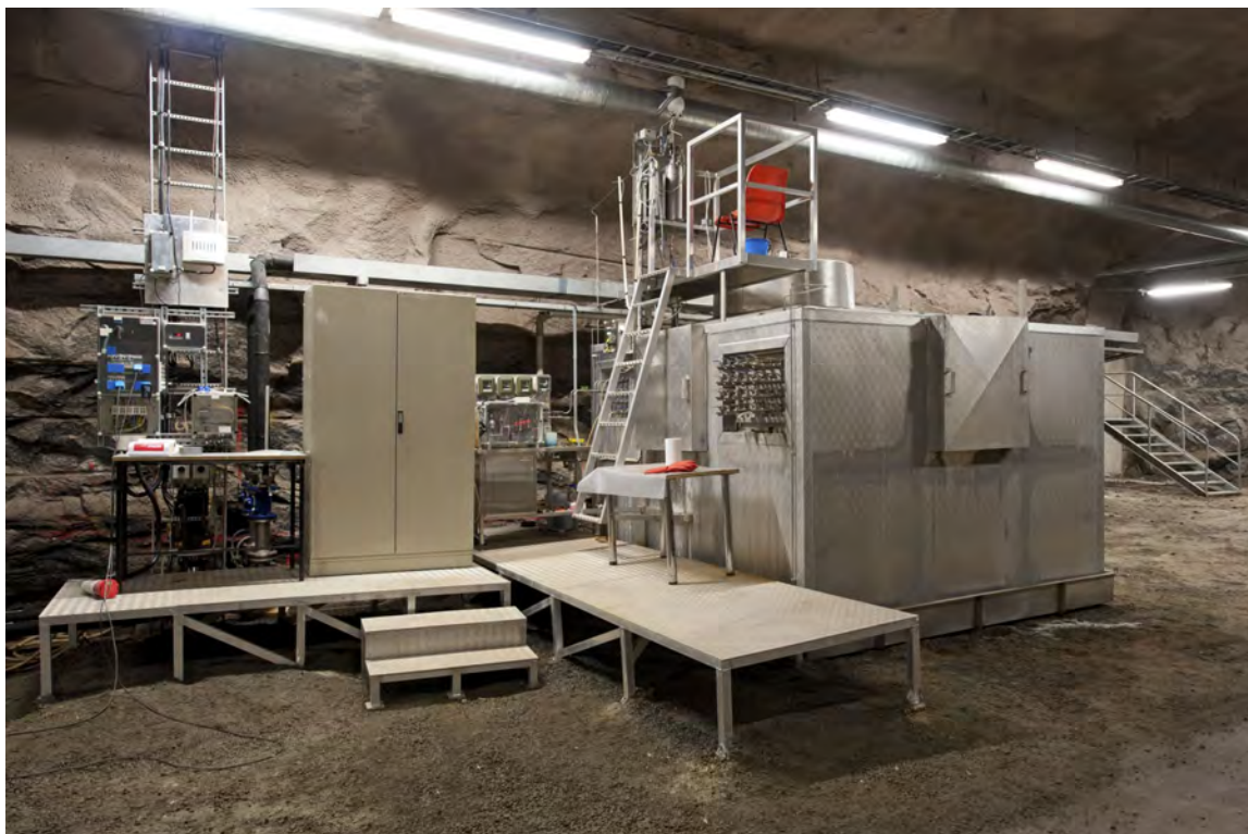
Kuva 3-4. Kaasunkehityskoelaitteisto Olkiluodon VLJ-luolassa.
