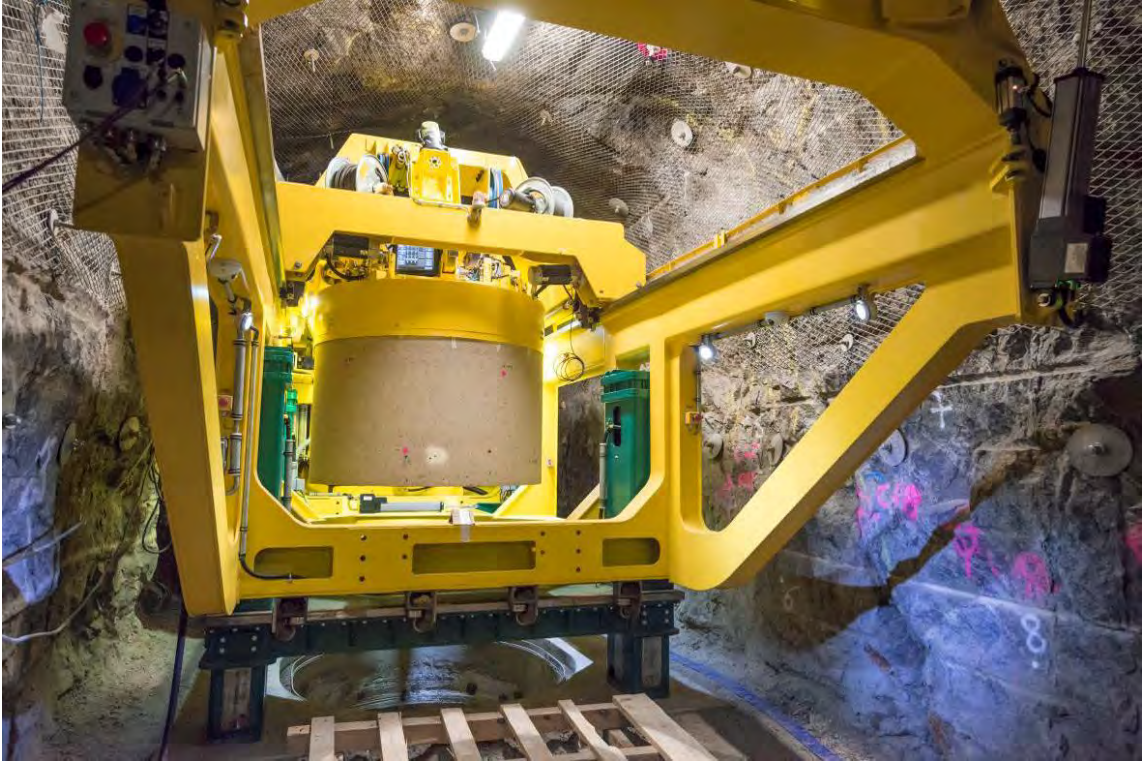
Kuva 5-3. Puskurilohkojen asennusta ONKALOn demonstraatiotunnelissa.
