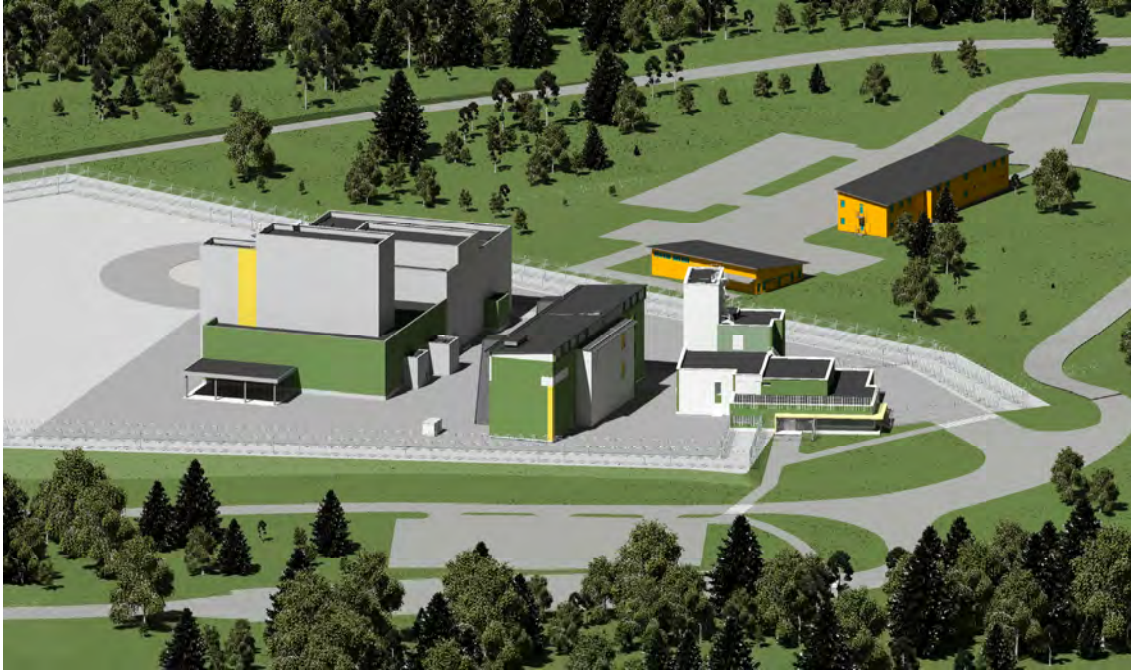
Kuva 6-2. Havainnekuva kapselointilaitosalueesta. Rakennukset vasemmalta oikealle: kapselointilaitos, ilmanvaihtorakennus, nostinlaiterakennus, tutkimushalli (takana) ja projektitoimisto.
