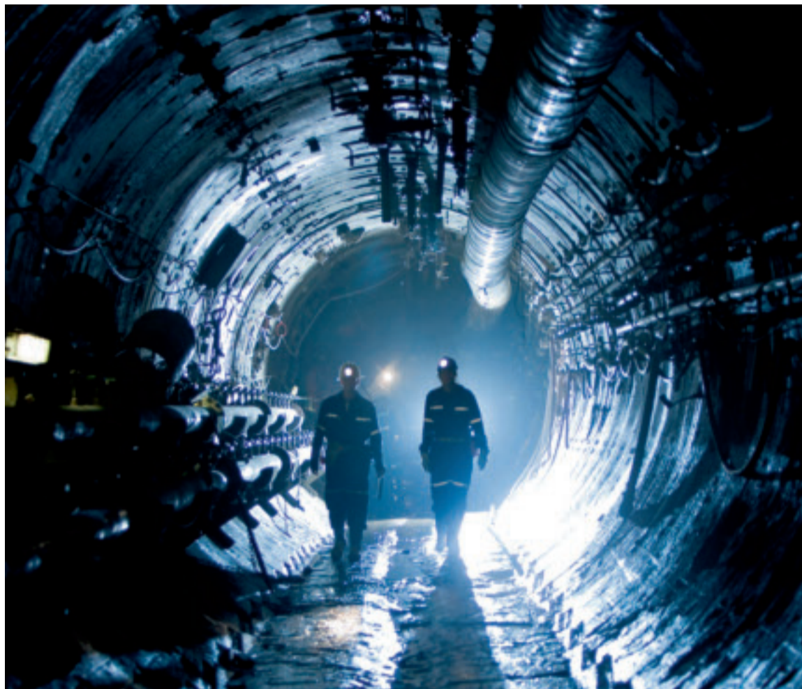
Kaivostunnelit on vahvistettu betonilla turvallisen työympäristön varmistamiseksi.
