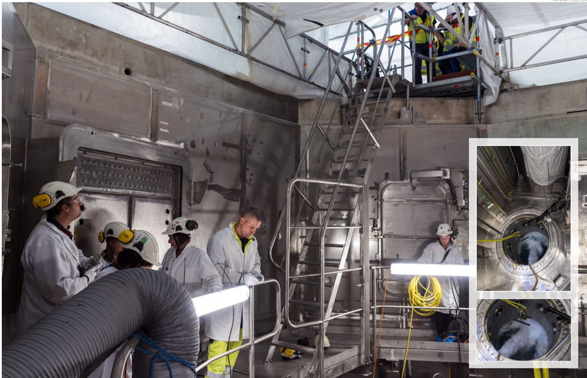
Primääripiirin huuhtelulla varmistetaan putkistojen ja reaktoripainesäiliön puhtaus ennen laitoksen ydinteknistä käyttöönottoa. Reaktoripainesäiliön halkaisija on noin neljä metriä.
