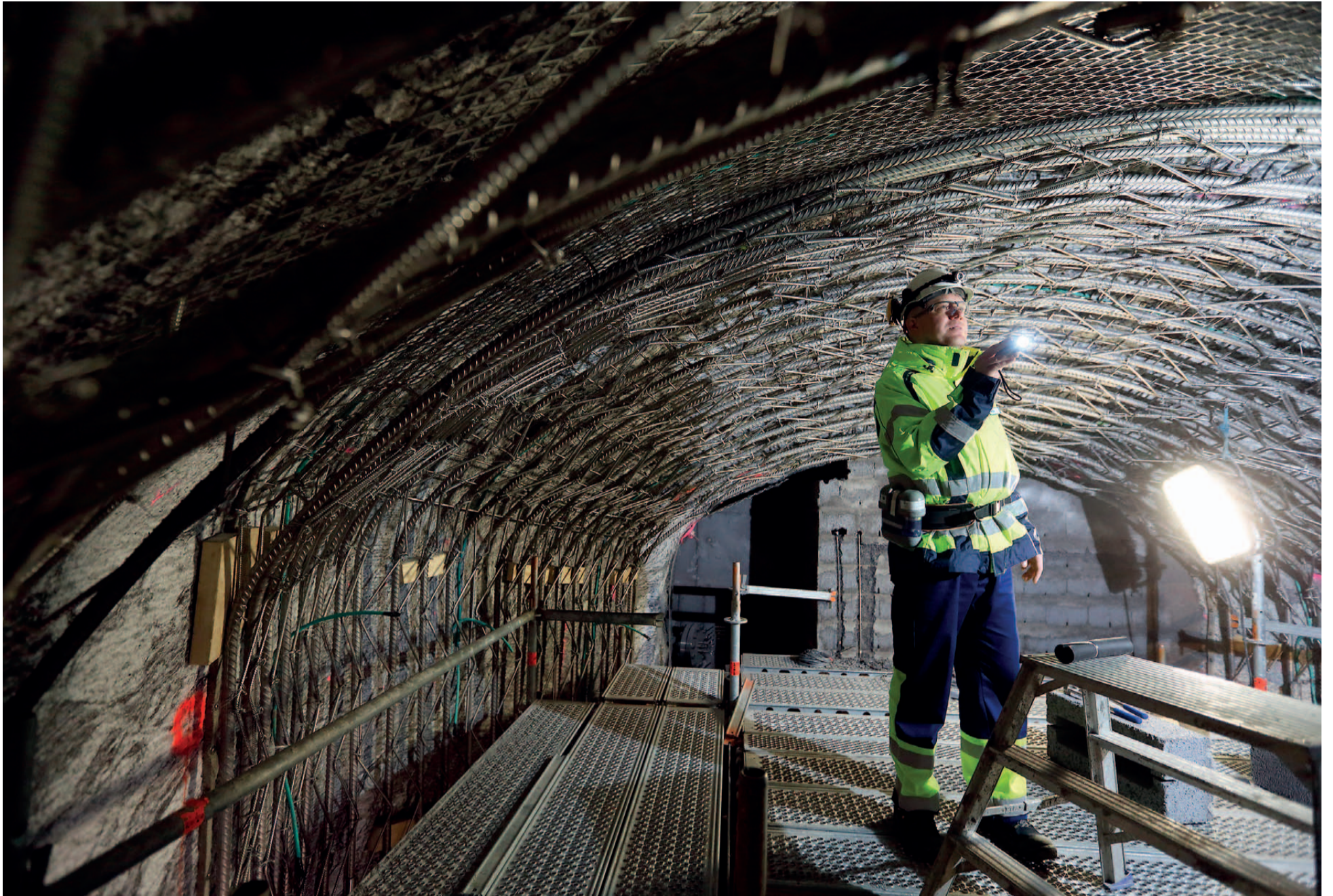
Teräsbetonitulpan ulkokehällä on asennettu halkaisijaltaan 32 millimetrin teräsverkotusta. Posivan Petri Koho tutki ONKALOSSA työn lopputulosta. Alakuvassa näkyy, miltä teräsbetonitulppa näyttää valmiina loppusijoitustunnelissa.
