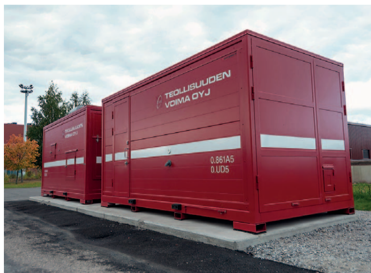
Uudet palovesipumput on sijoitettu siirrettäviin kontteihin.
