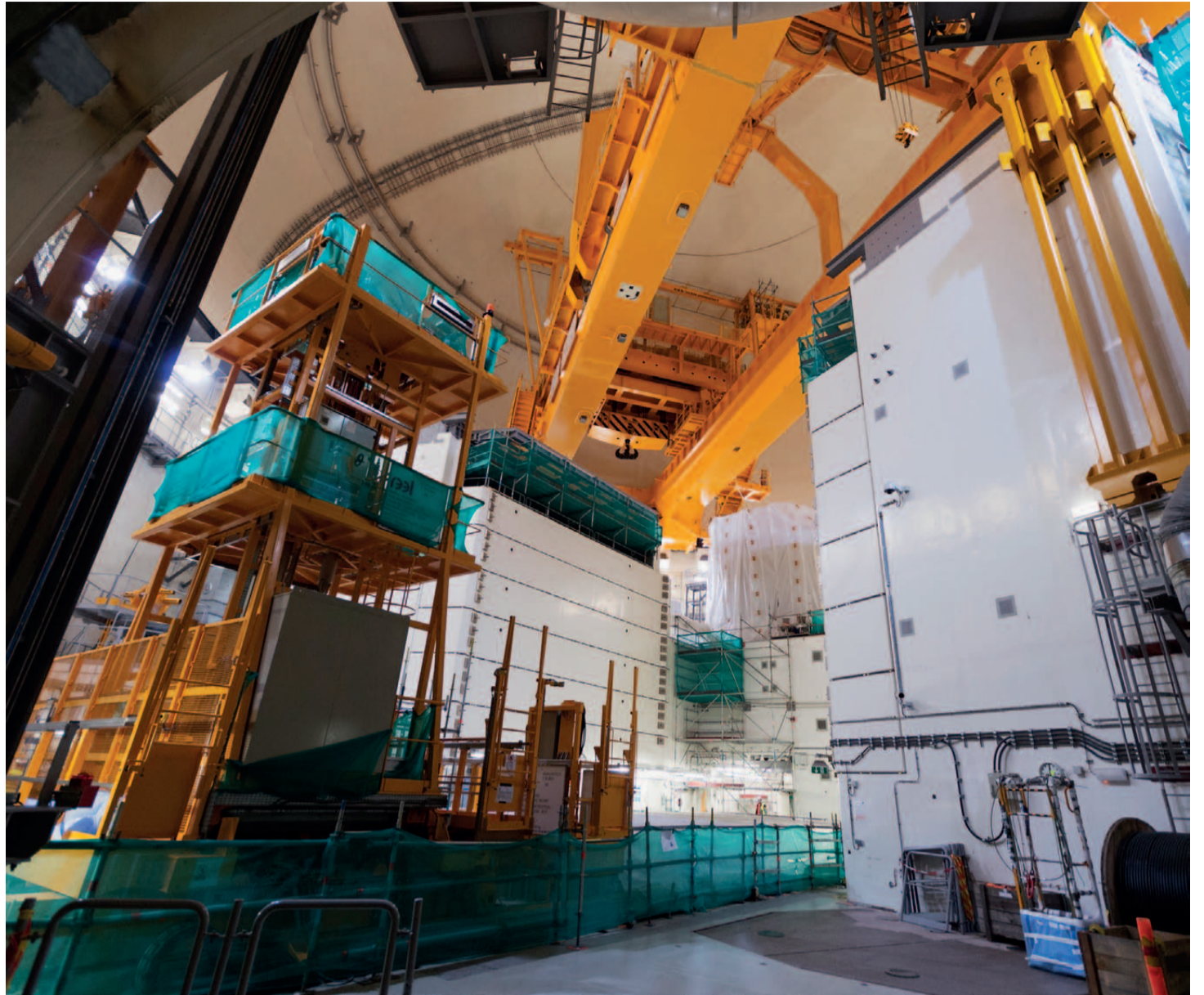
Uuden laitospäätösten sisätilat ovat hienosäätöä vaille valmiit. Pintojen viimeistelymaalauksissa on silti vielä työsarkaa jäljellä.
