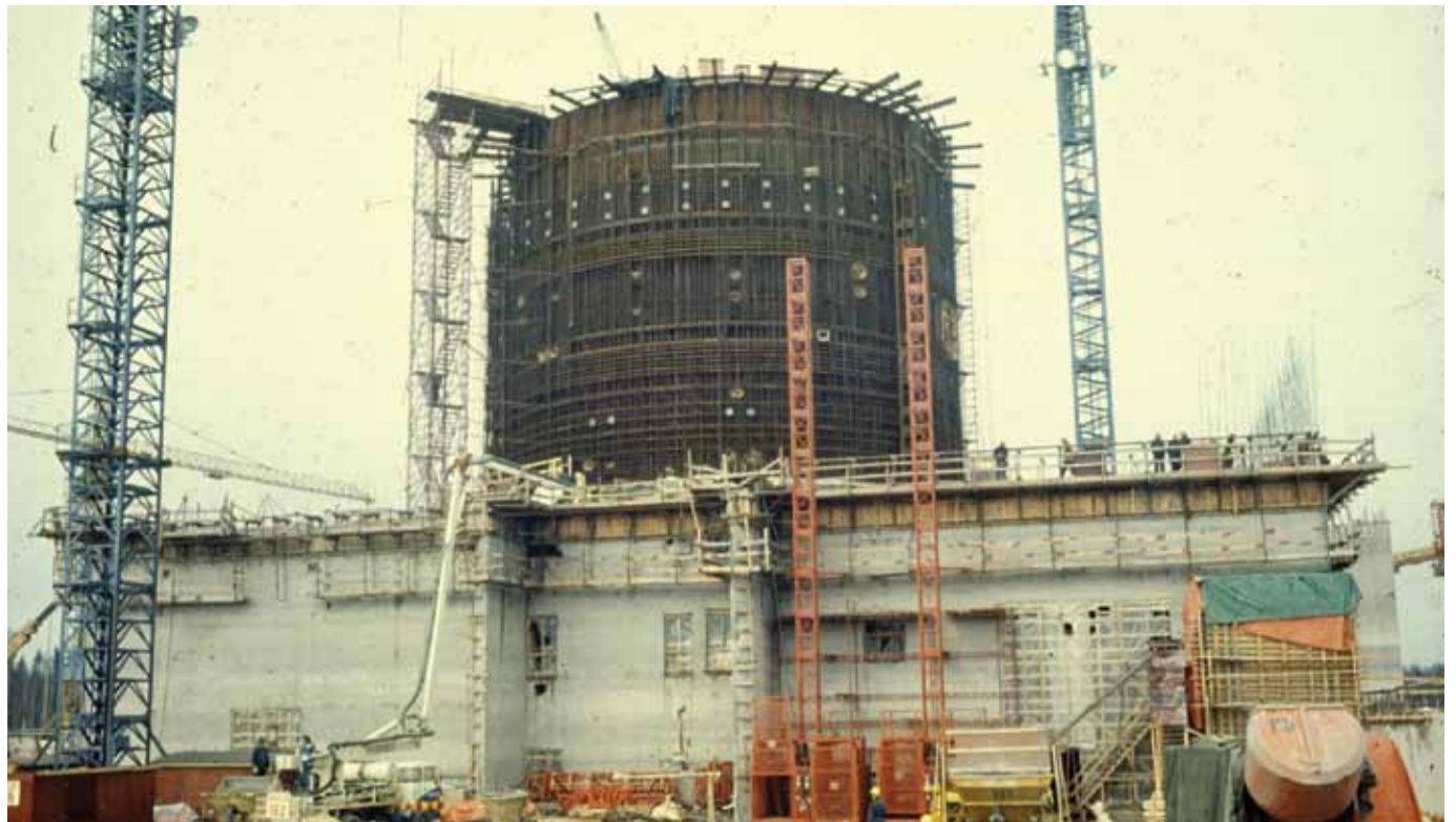
OL:n reaktorin suojarakennus nousemassa.
