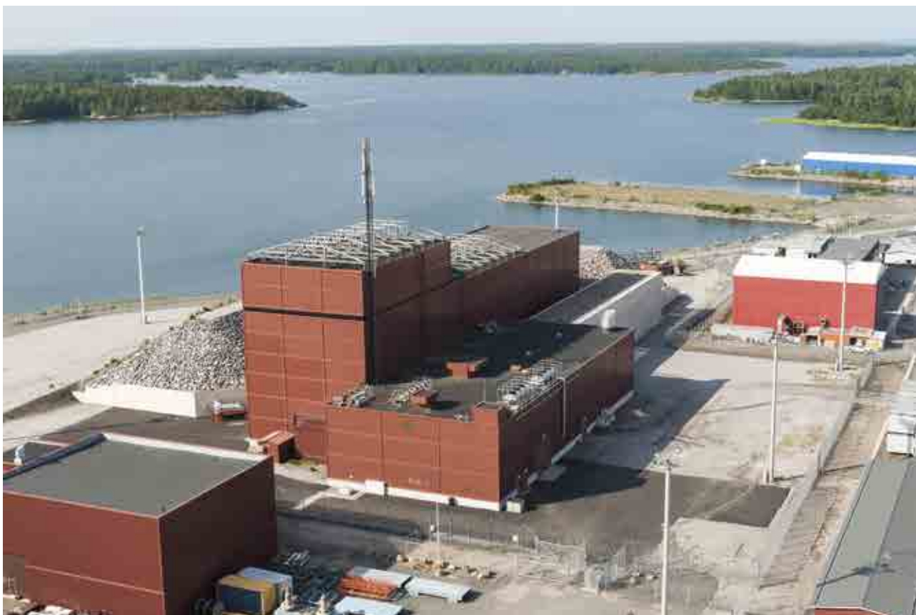
Bild 11. Mellanlagret för använt kärnbränsle (AK-lagret) ligger på anläggningsområdet och där kyls det använda kärnbränslet ned till dess att det placeras i slutförvar i Posivas slutförvaringsanläggning på Olkiluoto.
