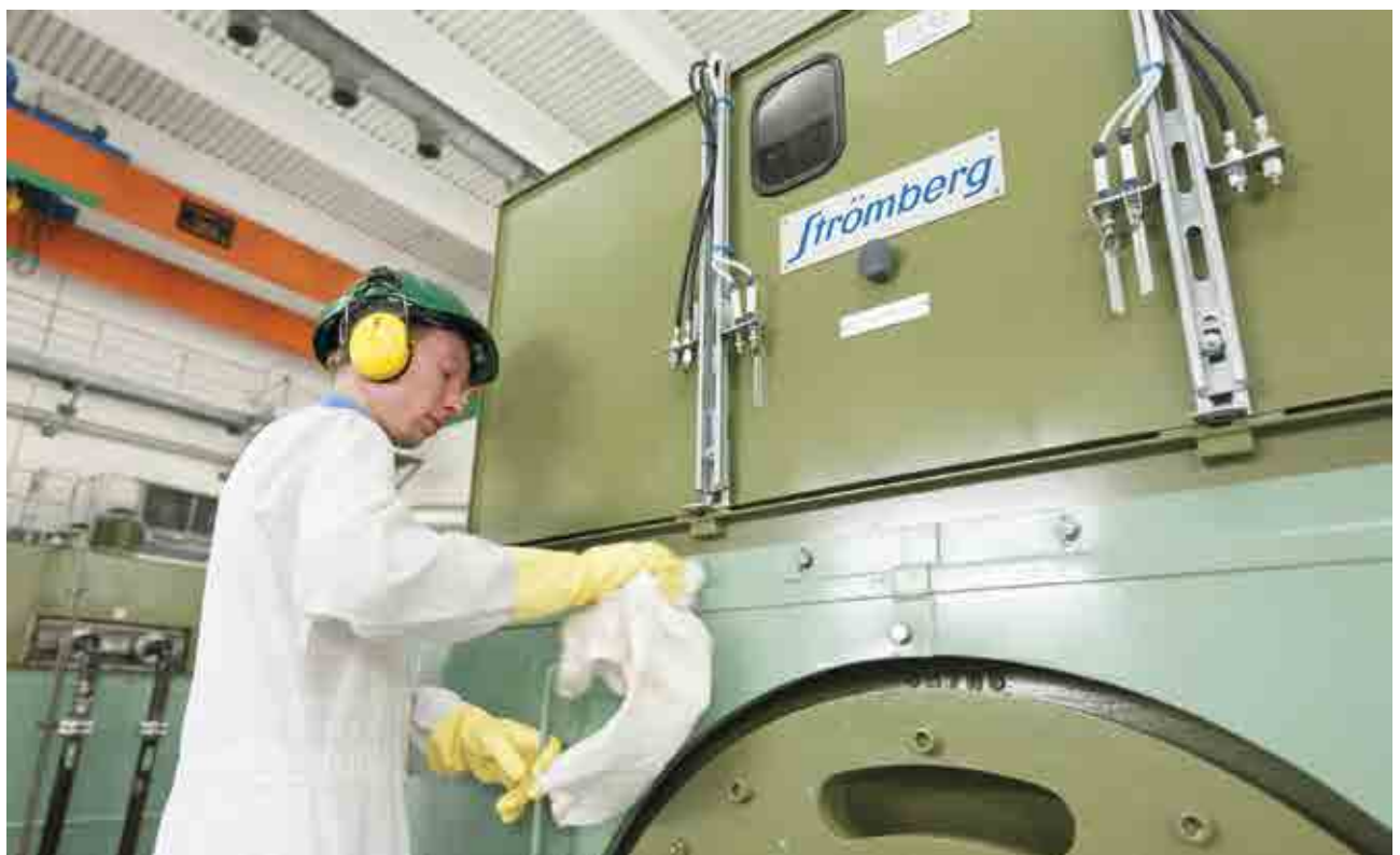
Bild 9. Hantering av åldrande, konditionsövervakning och underhåll utgör grunden för en säker drift av anläggningsenheterna.
