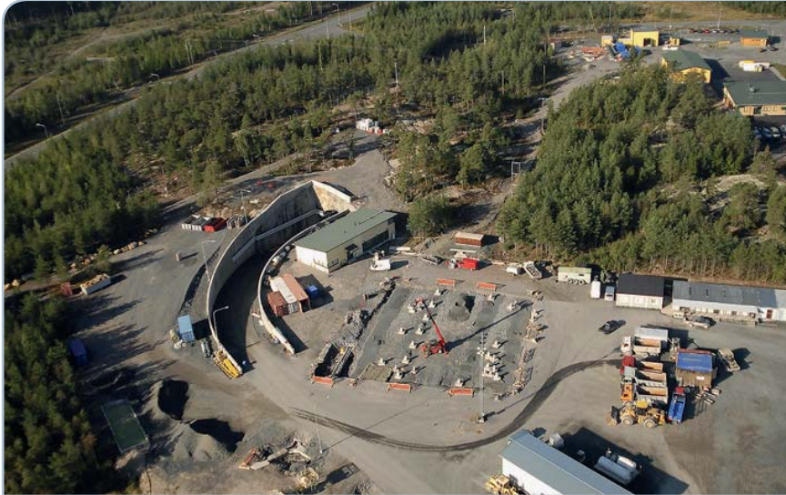
Kuva 14–2 Käytetyn polttoaineen loppusijoituksen tutkimustilaan (ONKALO) vievän tunnelin suuaukko Olkiluodossa. Tutkimustila muodostaa aikanaan osan käytetyn polttoaineen loppusijoitustilasta.
