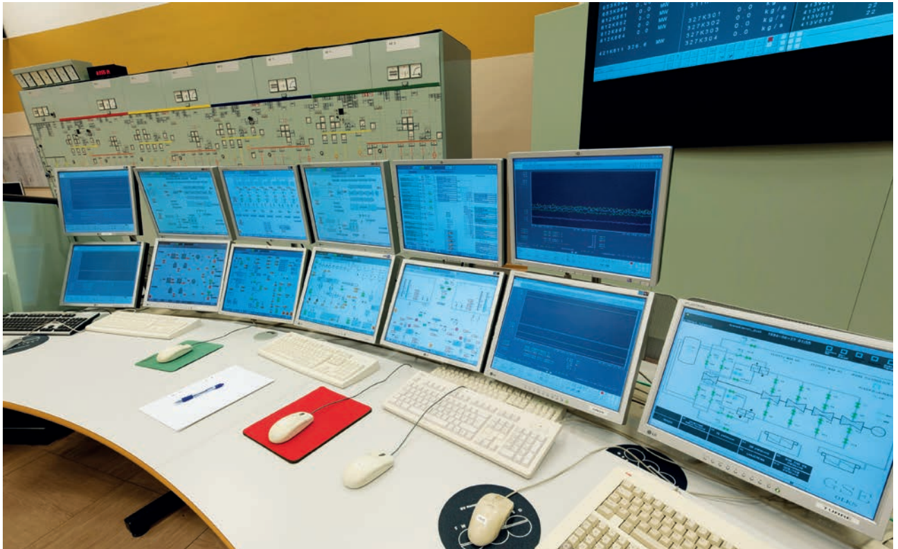
Turbiinaautomaation ohjaus- ja näyttöyöasemat
