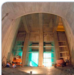
Jäähdytysveden sisäänottotunnelin poikkipinta-ala on noin 60 m 2 .
