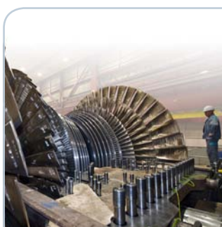
OL3:n matalapaineturbiinit ovat kaksivirtaustyyppisiä, ja niiden juoksusiivet on kiinnitetty turbiinin akseliin kutistusliitoksella liitettyihin siipikiekkoihin.
