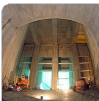
Jäähdytysveden sisäänottotunnelin poikkipinta-ala on noin 60 m 2 .
