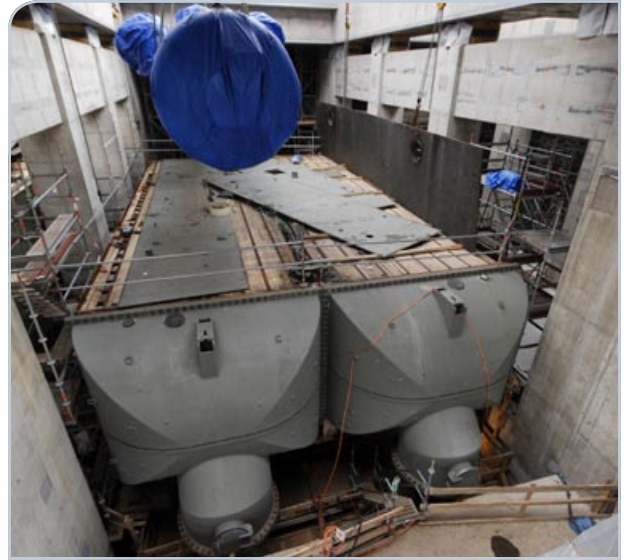
Lauhdutinlohkon merivesikammioita asennettuna paikoilleen.
