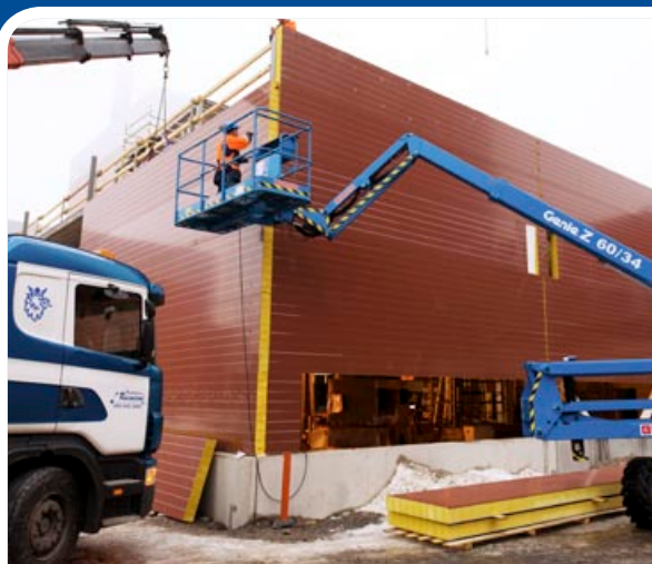
Uuden vuosihuoltorakennuksen rakentaminen jatkui ja se valmistuu vuoden 2009 vuosihuoltoihin.
